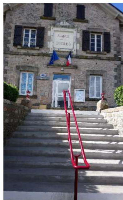
Nouvel escalier d'accès à la mairie et à l'école
